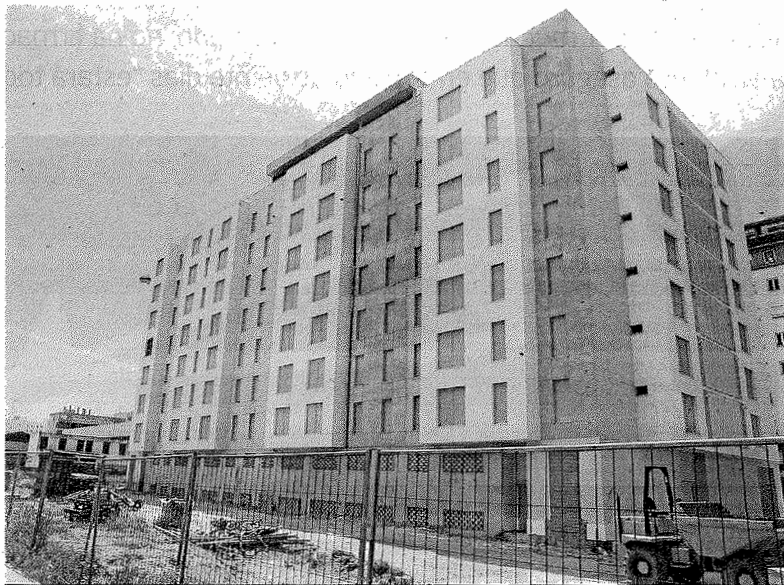
Las viviendas de Matadero se encuentran casi finalizadas.
